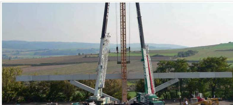
Bewohner in Gars am Kamp bekamen am vergangenen Wochenende eine beeindruckende Show zu sehen. Zwei Kräne spannten in kurzer Zeit eine Klappbrücke auf.
