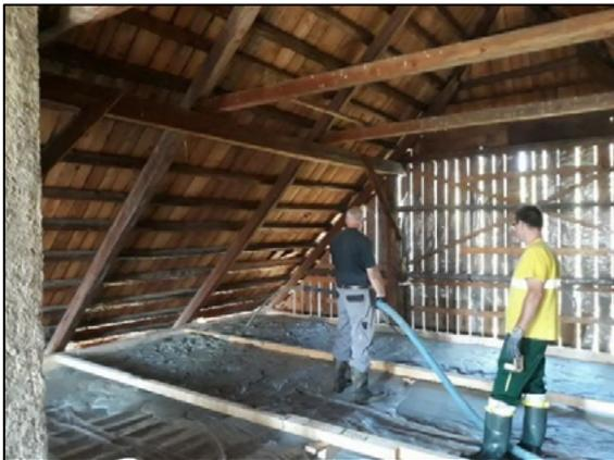
Abbildung 4 Dämmung eines 300 J. alten Bauernhauses
