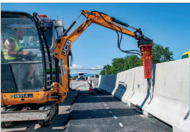
Bild 42: Verankerung der Elemente
