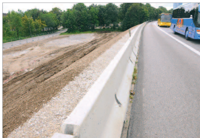
Bild 24: verankertes System an Böschung
