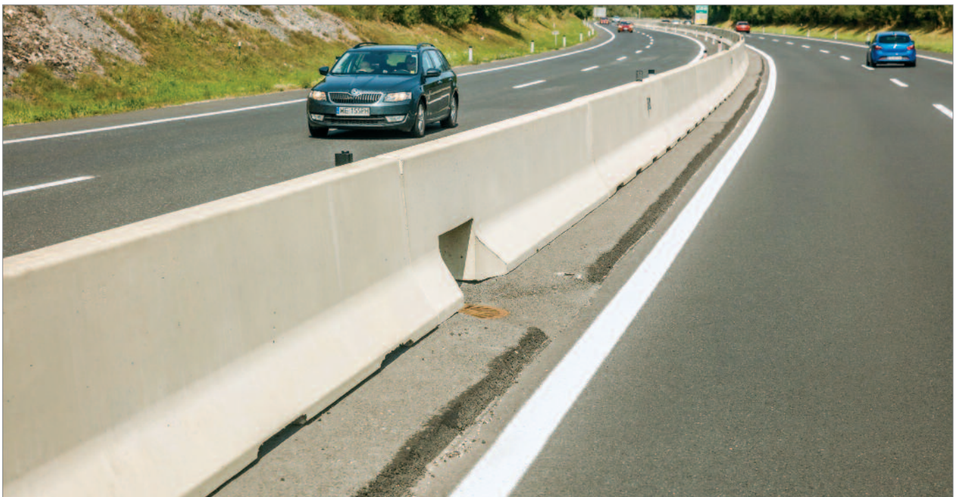
Bild 45: Ausnehmung in der Betonleitwand über Einlaufgitter
