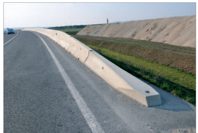
Bild 27: Rampe als Anfangskonstruktion
