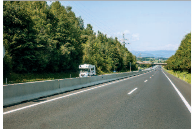
Bild 13: Leitwand innerhalb des Mittelstreifens
