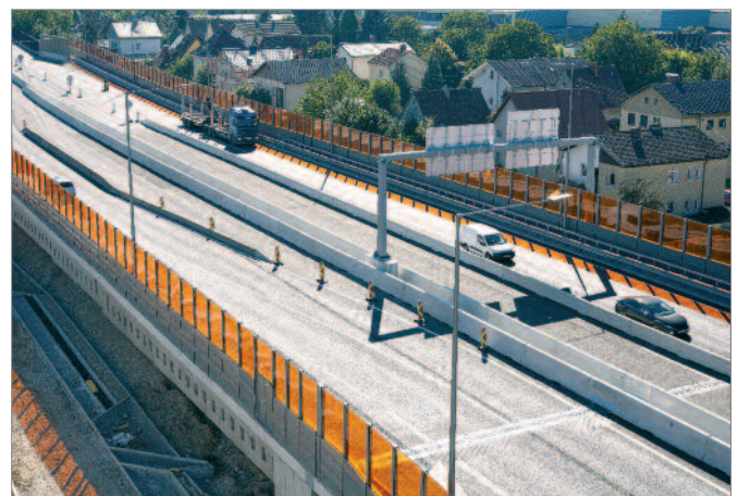
Bild 19: Mittelabsicherung auf Brücke
