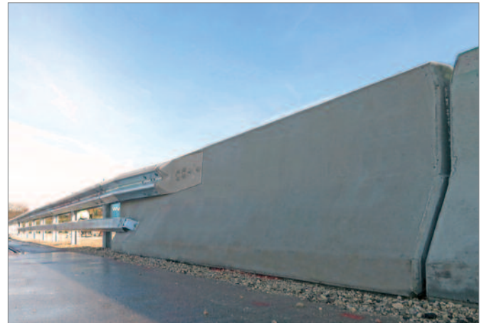
Bild 26: geprüfte Übergangskonstruktion gemäß ÖNORM EN 1317-4
