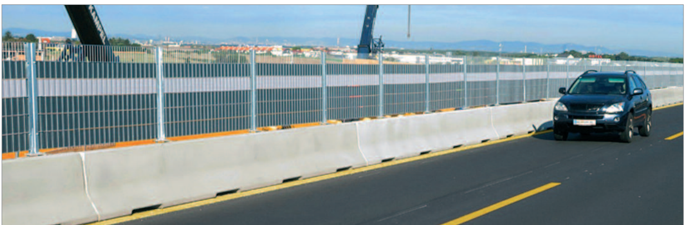
Bild 35: Leitwandsystem mit kombiniertem Sicht-, Blend- und Spritzschutz
