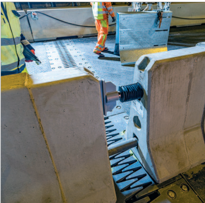
Bild 20: Leitwand mit Brückendilatation für Dehnweg 25 cm
