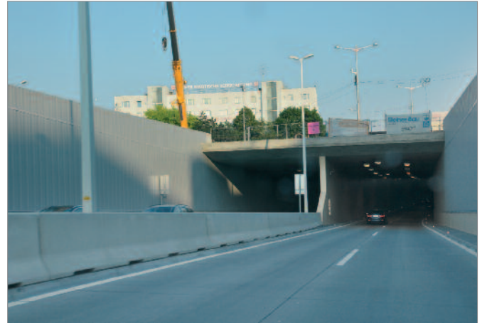
Bild 18: Leitwandanschluss an Tunnelportal
