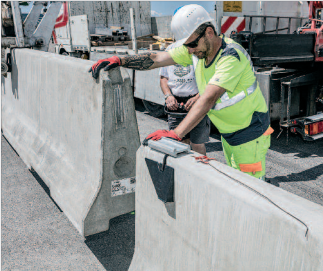
Bild 39: Zusammenschluss der Elemente
