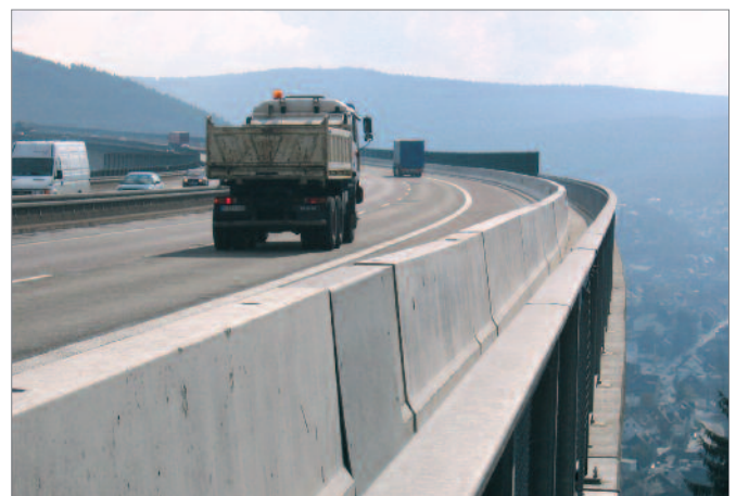
Bild 25: Randabsicherung auf Brücke inklusive Dilatation
