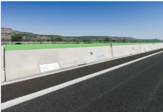
Bild 22: Elemente für Notfallöffnung (grün markiert)
