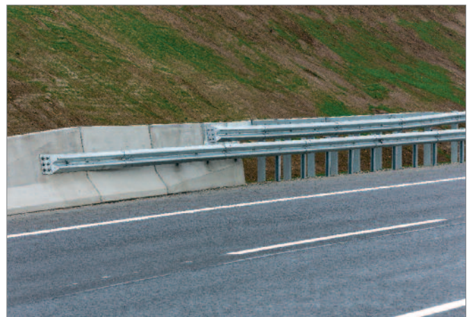
Bild 21: geprüfte Übergangskonstruktion gemäß ÖNORM EN 1317-4
