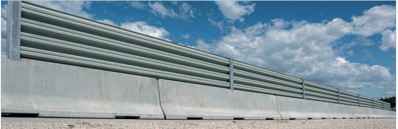
Bild 33: Leitwandsystem mit kombiniertem Sicht-, Blend- und Spritzschutz
