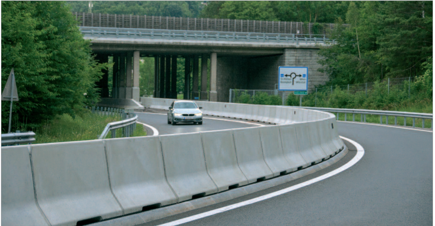
Bild 44: Kurvenausbildung mit kurzen Elementen bei engen Kurvenradien
