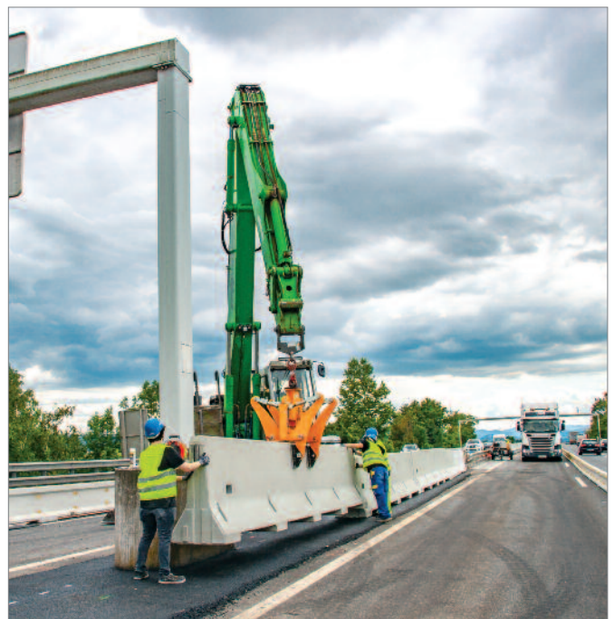
Bild 37: rasche Montage mit Hebezeuge
