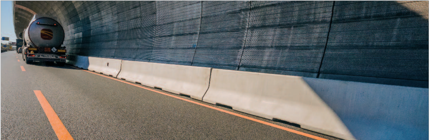
Bild 12: integrierte Entwässerungsöffnungen
