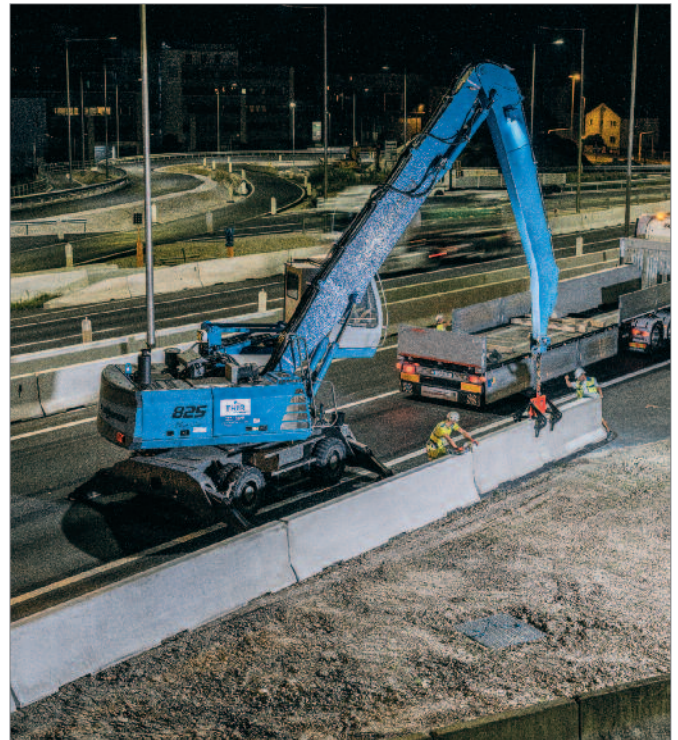
Bild 36: Geringe Beeinträchtigung des Verkehrs durch rasche Montage
