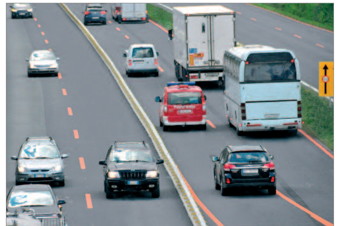
Bild 29: Bauliche Trennung bei Gegenverkehr
