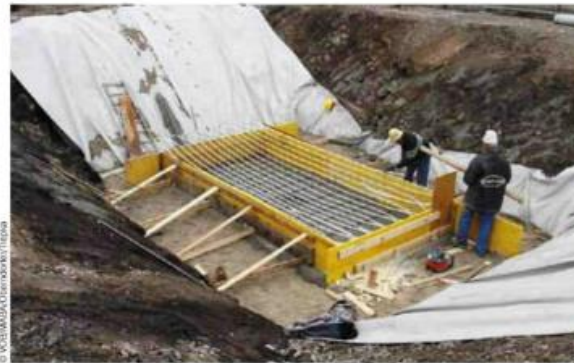
„Keller thermisch aktiviert“: Schalung für Keller-Bodenplatte wird eingerichtet.
