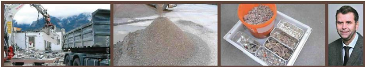
Foto 1: Holzbetonhaus beim Abbruch | Foto 2: Trennung von Holzspänen | Foto 3: Materialien nach der Trennung | Foto 4: „Holzbeton und Kernbeton werden jedoch bislang kaum getrennt. Durch die Trennung können die Bestandteile deutlich besser als bisher verwertet werden.“ Gernot Brandweiner, VÖB
