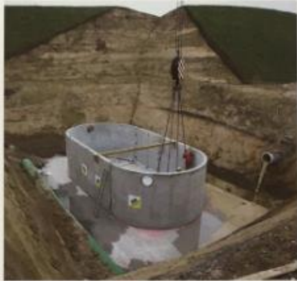
Inzersdorf: VÖB Mitglied SW-Umwelttechnik versetzt Großabscheideanlage, www.flickr.com/gp/himmelhoch . © VÖB
