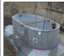
SW Umwelttechnik versetzt Großabscheideanlage am neuen ÖBB Terminal Inzersdorf.
