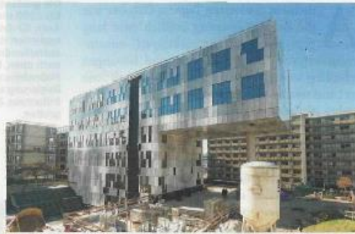
Baustelle der BIG am Campus der MedUni in Graz.
