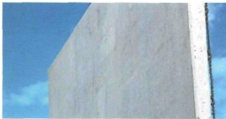
Der umweltfreundliche Beton verursacht bis zu 30 Prozent weniger CO 2 -Emissionen in der Herstellung im Vergleich zu Standardbeton mit gleichen Eigenschaften. FOTOS: IMBT - TU GRAZ
