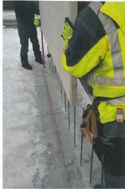
In Bischofshofen steht die Baustelle trotz Schnee und Minusgraden nicht still. Zu verdanken ist das den Betonfertigteilen, die zum Einsatz kommen.
