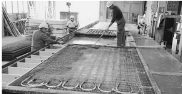
Die Produktion der Wandelement bei der Firma Maba.
