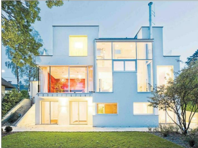
Die hohe Qualität und regionale Verankerung der Massivbauweise stärkt in Österreich auch ... [www.rumschhaus.at]
