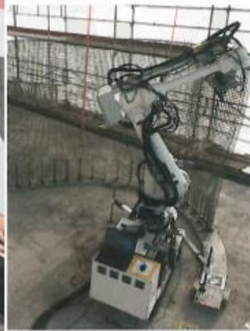
Das DFAB House in der Schweiz wird mit Hilfe von Robotern und 3D-Druckern errichtet.
