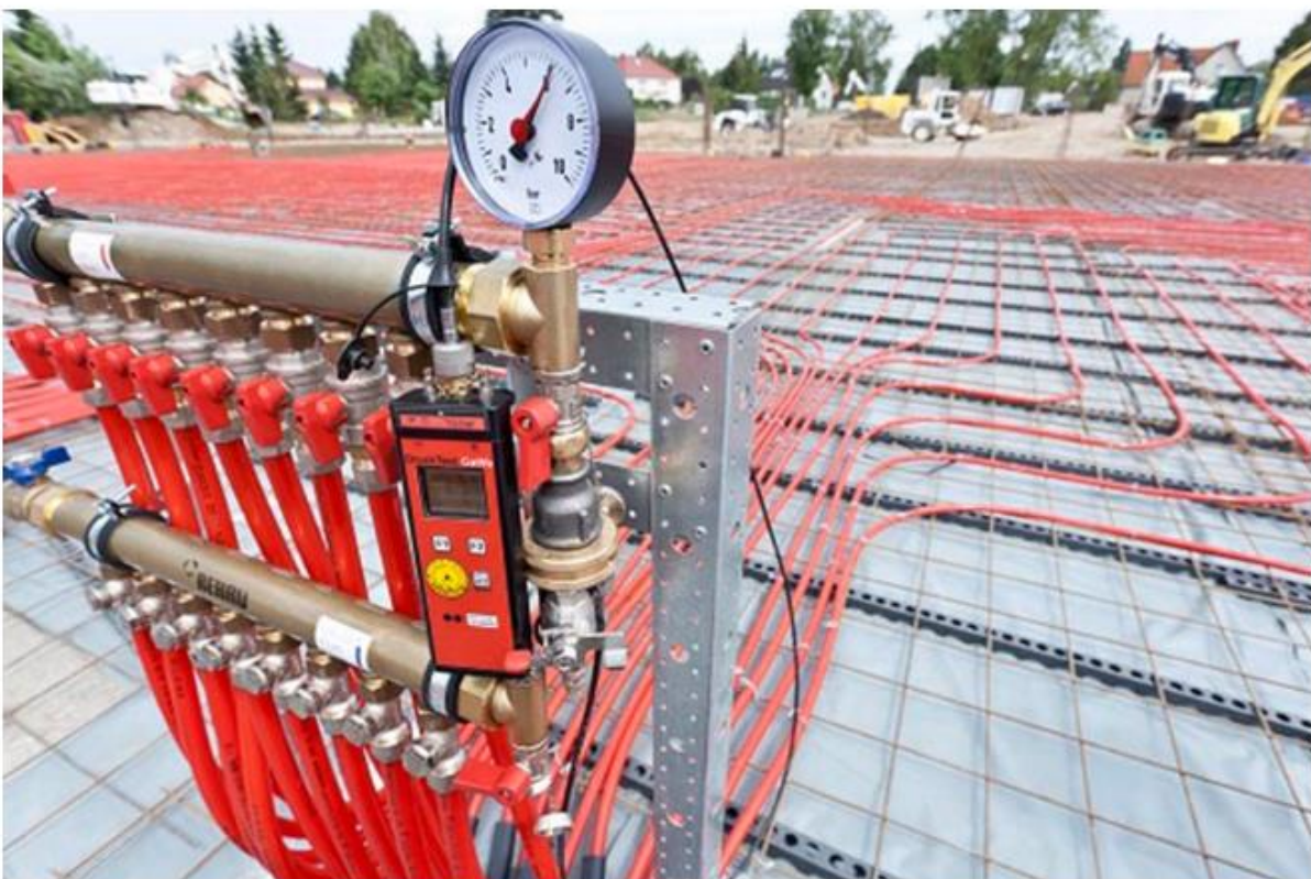
Foto: Rohrleitungen für thermisch aktivierte Decken (Bildrechte: Rehau)
