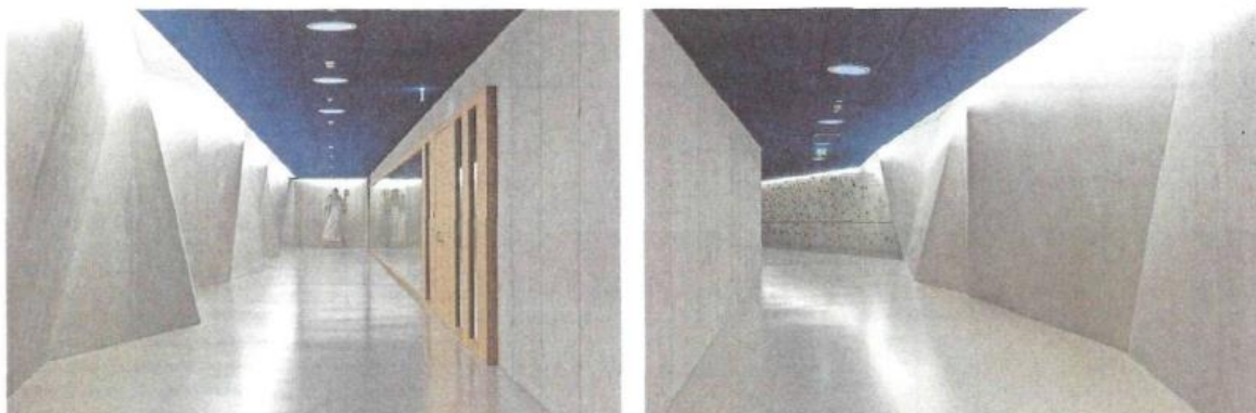
Das scharfkantige Fugenbild der gefalteten Ortbetonwand wurde präzise geplant und auf technisch hohem Niveau umgesetzt. Trichterförmige, symmetrische Oberlichten und dazwischen liegende Lichtbänder sorgen für hohe Tageslichtqualität. FOTOS: WALTER EBENHOFER
