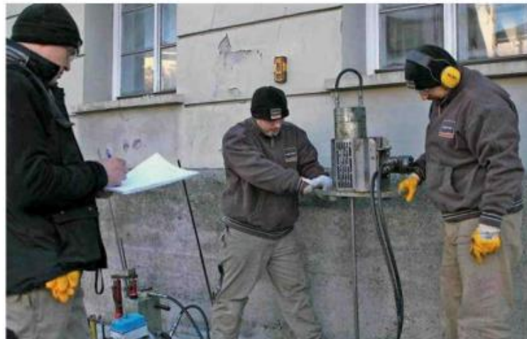
In Salzburg wurde mit der Uretek-Methode ein denkmalgeschütztes Gebäude saniert
