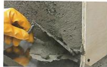
Der R3 Mörtel Nafufill KM 230 kann bis zu 60 mm dick appliziert werden.
