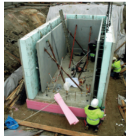
Die Außenwände des Forschungskellers werden aufgebaut
