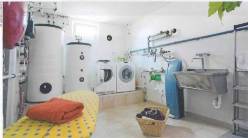
Keller schaffen um bis zu 40 % zusätzlichen Wohn- und Lebensraum und steigern den Wert der Immobilie.
