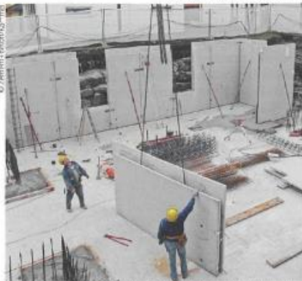
Fertigkeller aus Beton sind in wenigen Tagen errichtet und können optimal gedämmt werden.
