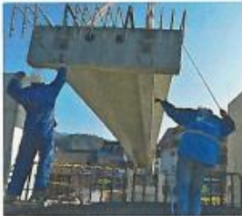
Schlanke Konstruktion mit Betonfertigteilen beim Steg über den Wölzerbach
