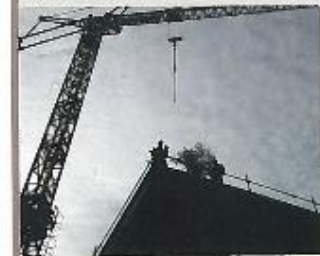
Firstfeier der Wohnanlage »Wallenmäh«, die auch als Forschungsobjekt für alternative Be- und Entlüftungskonzepte dient.
