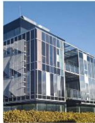
Blick auf die Südseite des FIBAG-Quartiers in Stallhofen mit integriertem MPPF-Prototyp.
