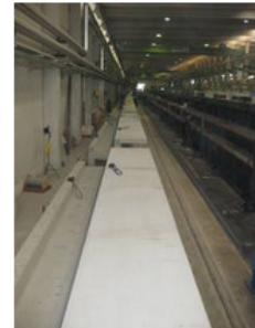
Tribülenelemente in der Fertigung
