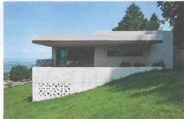
Beton ermöglicht kreatives Bauen und ausdrucksstarke Ästhetik. Längst gilt Beton auch als der Baustoff, mit dem sich dauerhaft Energie sparen lässt. Das Wohnhaus wurde aus braunem, korngefärbtem Beton errichtet und die Oberfläche danach sandgestrahlt.
