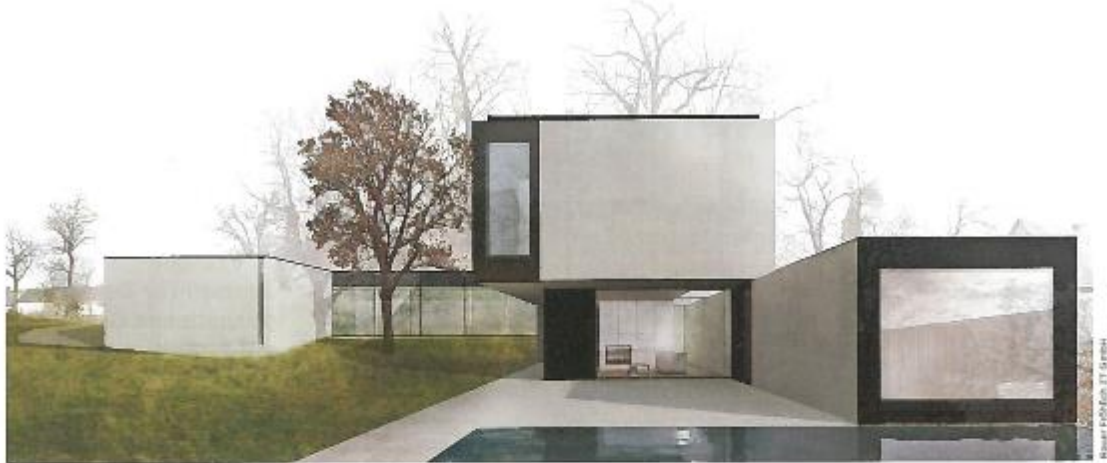
Fortschrittliche Häuslbauer: Bei diesem Einfamilienhaus in der Nähe von St. Pölten wurden Betonwände im Erdgeschoß sowie die Obergeschoßdecke bauteilaktiviert.
