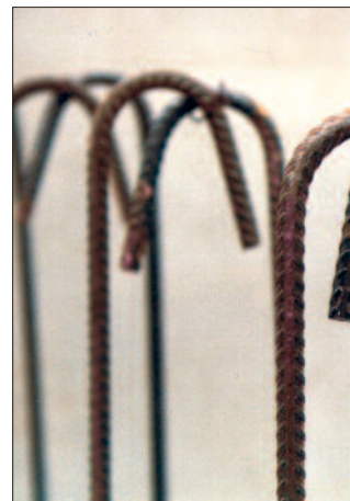
Bild 3: Steckseisenendhaken zur Wandmitte ausrichten
