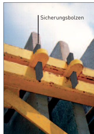
Bild 6: Sicherungsbolzen für benötigtes Element entfernen
