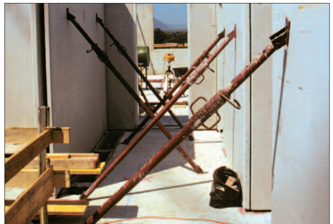
Bild 16: Sicherung der Wandelemente mit Schrägstützen
