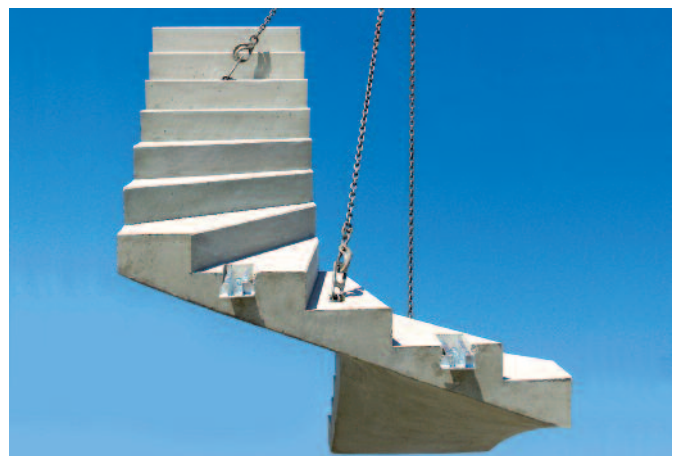
Bild 9: Treppe am Kran im Montagelage
