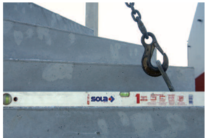
Bild 12: Stufen müssen quer zur Laufrichtung waagrecht liegen
