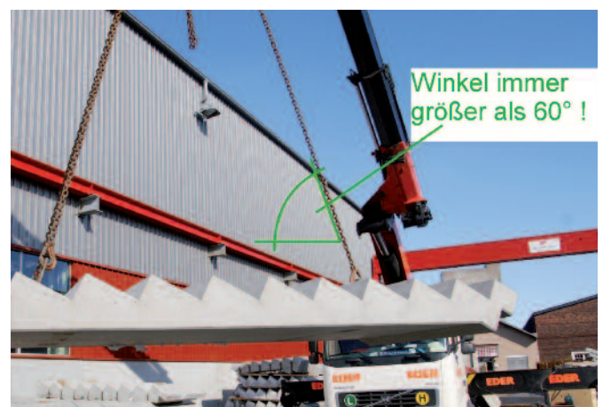
Bild 6: Neigung der Ketten muss größer als 60° sein!
