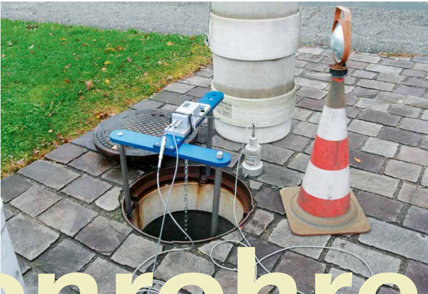
Schachtprüfung gemäß Pkt.: 6.5.4
