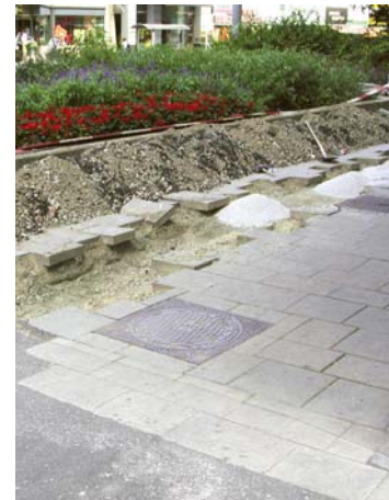
Die Wiederherstellung der gepflasterten Fläche ist im Gegensatz zu anderen Bauweisen ohne sichtbare optische Folgen an der Oberfläche möglich.
