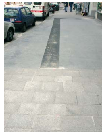
Die Wiederherstellung der gepflasterten Fläche ist im Gegensatz zu anderen Bauweisen ohne sichtbare optische Folgen an der Oberfläche möglich.
