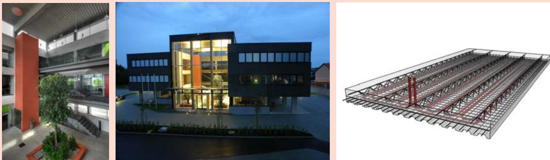
Abbildung 46: Die Firmenzentrale der Trepka GmbH in Obergrafendorf (Planung: Bauatelier Schmelz & Partner, Fotos: Fa. Trepka GmbH)
