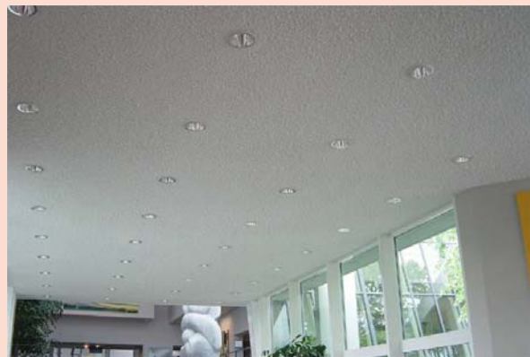
Abbildung 31: Akustikputz (Foto: Akustik und Malerei Fink 2 ).
