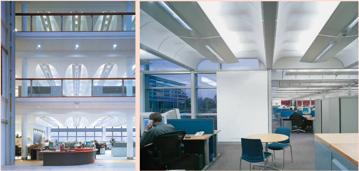
Abbildung 6: Vergrößerung der Luftaustauschfläche durch Strukturierung der Decke. Links: Powergen-Bürogebäude in Coventry, England. Rechts: Wessex Water Operations Centre in Bath, England. In beiden Gebäuden sind Akustik Elemente in die Beleuchtungskörper integriert. Architektur: Bennetts Associates Architects. (Fotos: Peter Cook).
