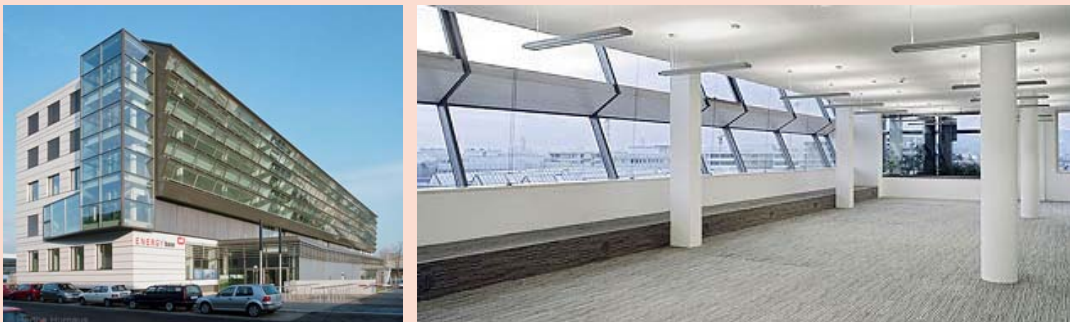
Abbildung 47: ENERGYbase in Wien. (Architektur: pos architekten; Fotos: Hertha Hurnaus)
