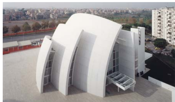
Abb. 1 und 2: Kirche „Dives in Misericordia“ von Richard Meier in Rom. Ein spezieller Zement mit Carrara-Marmor-Mehl-Beimischungen (TX Millennium der Fa. Italcementi, Bergamo) ist für die blendend weiße Oberfläche verantwortlich. Die zugesetzten Titandioxidpartikel sollen mit Hilfe des photokatalytischen Effekts die schöne Oberfläche über einen langen Zeitraum erhalten. Bildquelle: Fa. Italcementi
