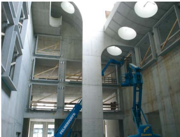
Bild 4: Montage auch im Inneren
