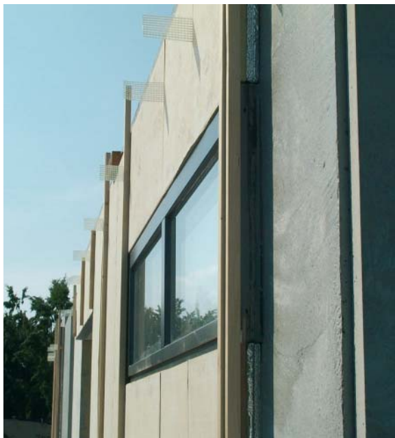
Bild 4: Detailansicht eines vakuumgedämmten Betonfertigteils mit integriertem Fenster. Teilweise sind zwischen den VIP-Fugen noch die Bandanker zu erkennen.
