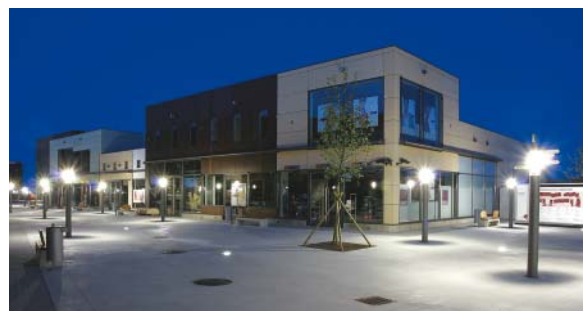
Outletcenter Leoville – 1.500 m 2 concrete skin, grün ferro, liquide black ferro, sandstein ferro, silbergrau ferro
