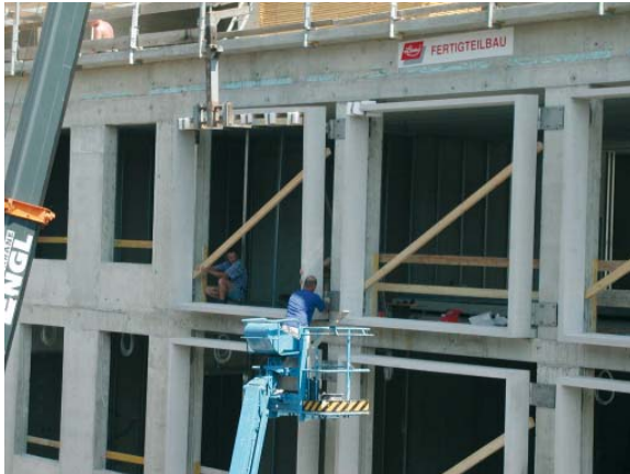
Bild 3: Montage Fensterrahmen
