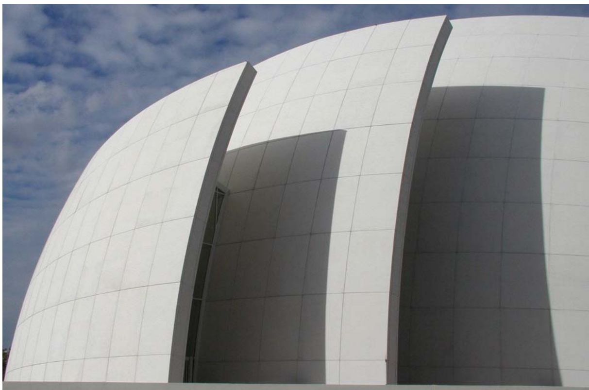
Abb. 1 und 2: Kirche „Dives in Misericordia“ von Richard Meier in Rom. Ein spezieller Zement mit Carrara-Marmor-Mehl-Beimischungen (TX Millennium der Fa. Italcementi, Bergamo) ist für die blendend weiße Oberfläche verantwortlich. Die zugesetzten Titandioxidpartikel sollen mit Hilfe des photokatalytischen Effekts die schöne Oberfläche über einen langen Zeitraum erhalten. Bildquelle: Fa. Italcementi
