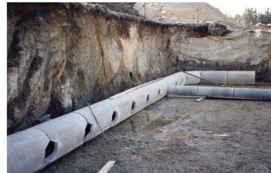
Bild 30: Luftkollektor-Verlegung (Foto: EVN)
