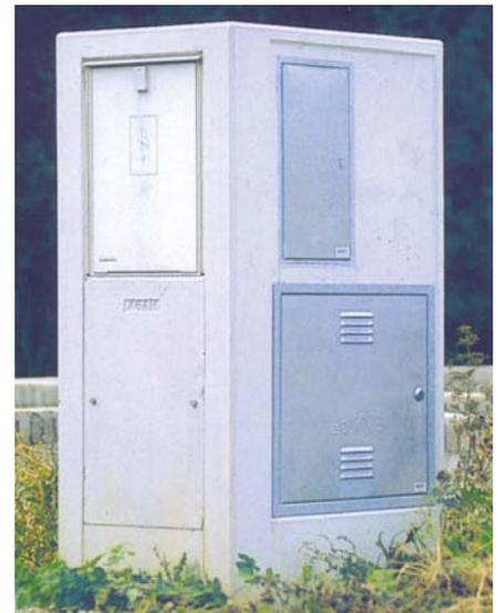
Bild 29: Hausanschluss-Bock (Foto: Firma Maba)
