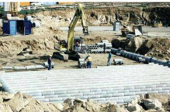
Bild 32: Luftkollektor-Verlegung (Foto: EVN)
