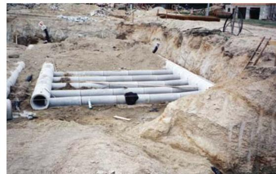
Bild 31: Luftkollektor-Verlegung (Foto: EVN)
