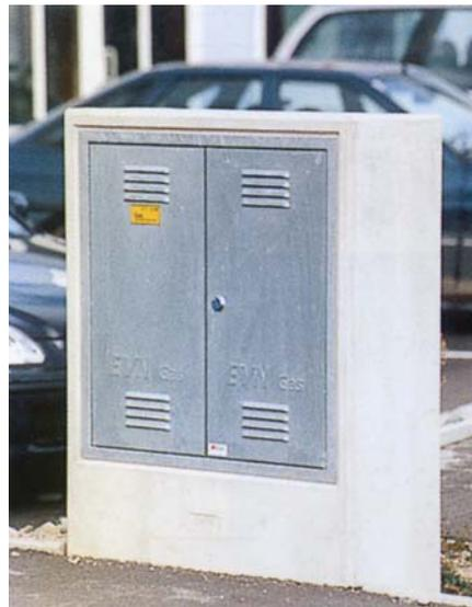
Bild 28: Hausanschluss-Bock (Foto: Firma Maba)
