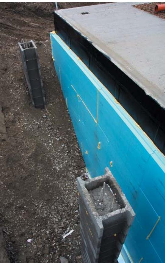
Bei bestehen bleibenden Baugrubensicherungen übernimmt die außen liegende Wärmedämmung zudem die Funktion einer Trennschicht zwischen Baugrubensicherung und Außenwand des Kellers. Schematische Aufbauten sind in Grafik 3-8 zusammengefasst. Aufgrund der besonderen Beanspruchungen, denen direkt ans Erdreich grenzende Wärmedämmschichten ausgesetzt sind, dürfen für Außendämmungen nur Dämmmaterialien verwendet werden, die
