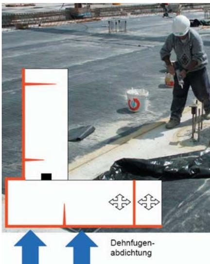
Grafik 4-27: Wirkung der Bentonitschicht (Aufquellen bei Feuchtezutritt)
