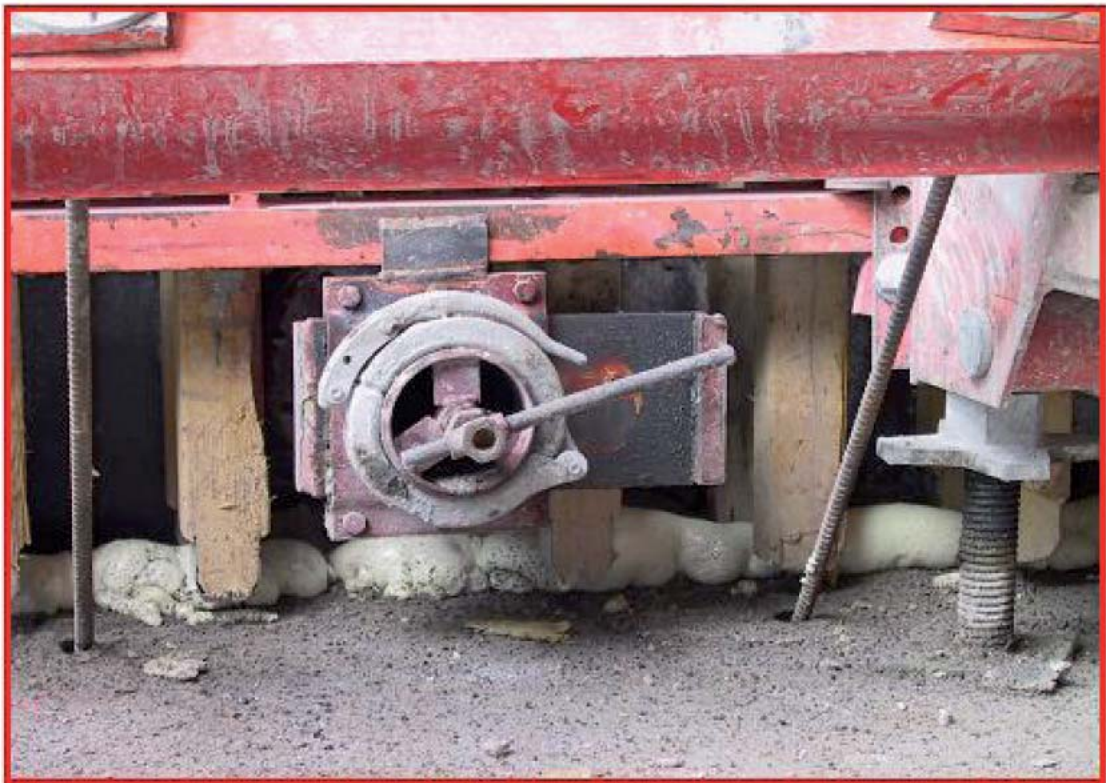
Abb. 10.1: Nach dem Pumpen von unten kann hervorstehender Beton bündig mit der inneren Oberfläche der Schalung mittels einer Spezialspindel angepasst werden oder die Oberfläche muss nach der Entfernung der Schalung ausgebessert werden.
