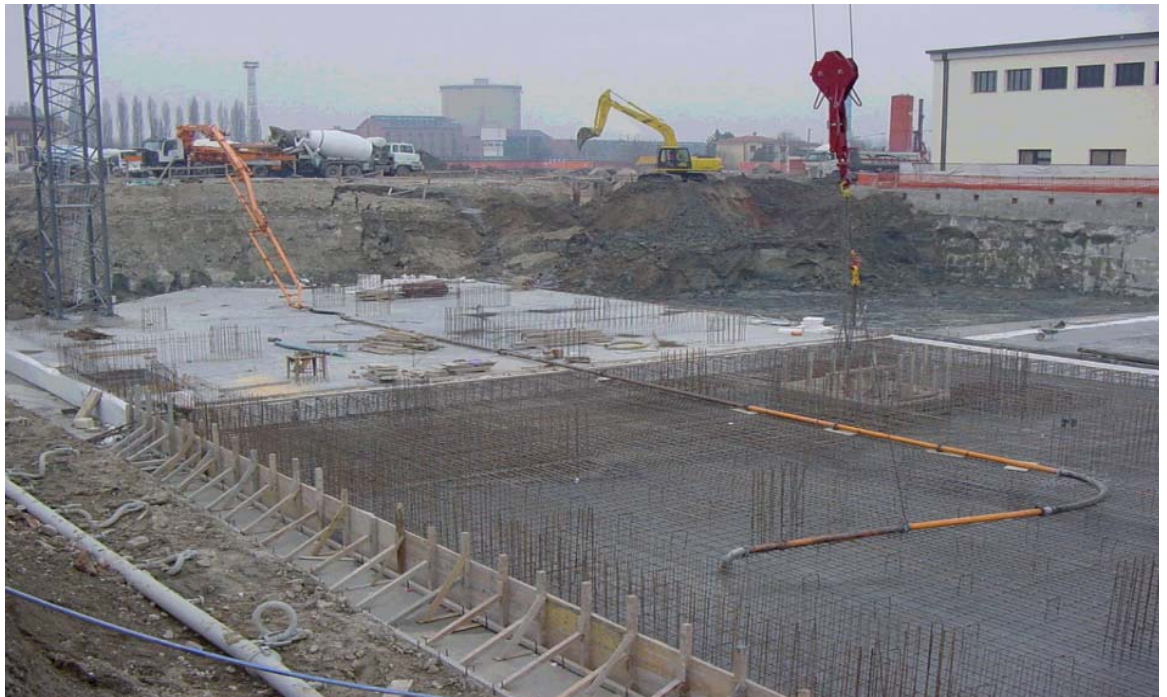
Abb. 11.1: Betonieren einer SCC-Platte. Handelszentrum, Ferrara, Italien
