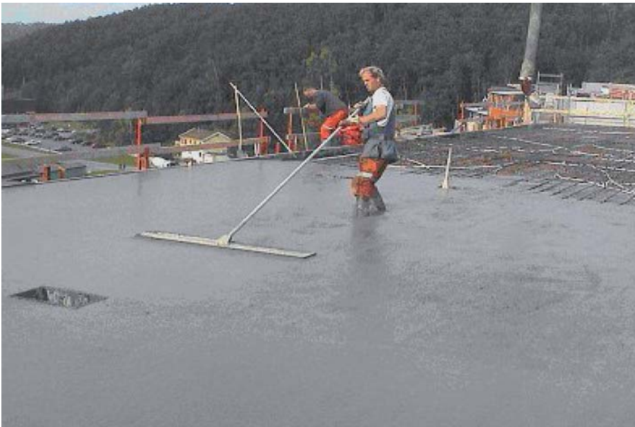
Abbildung 11.2: Abziehen von SCC mit einem Abziehbrett
