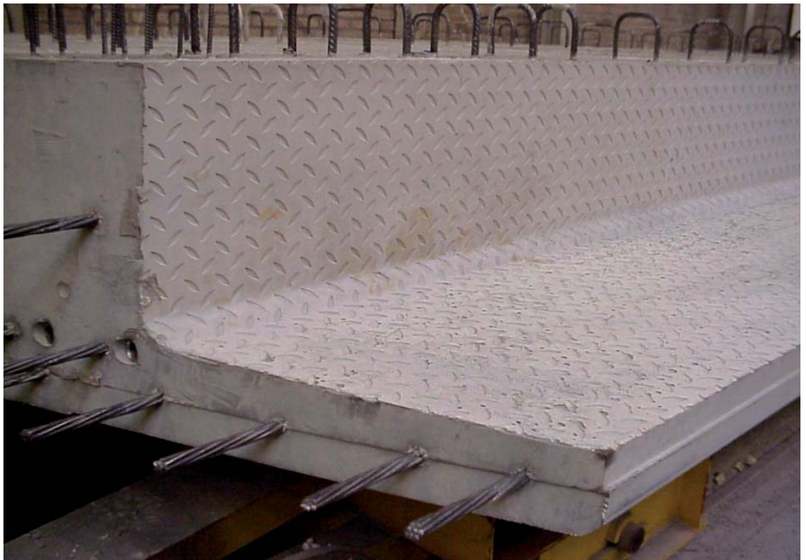
Abb. 5.1: Oberflächendetail eines Fertigteilelementes aus SCC
