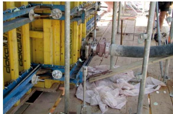
Abb. 19: Einbringen durch Einbringstutzen
