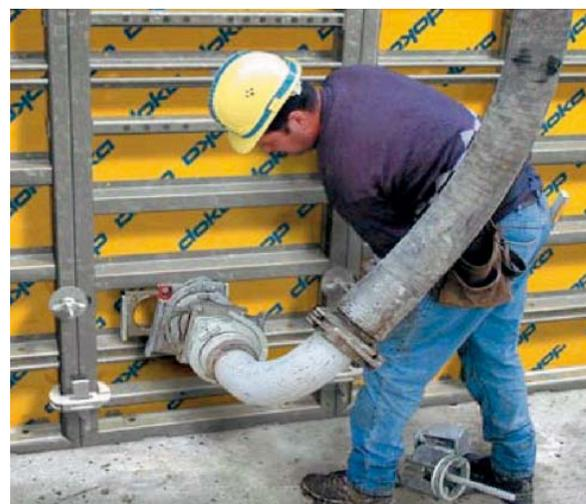
Abb. 20: Einbringstutzen in der Systemschalung integriert
