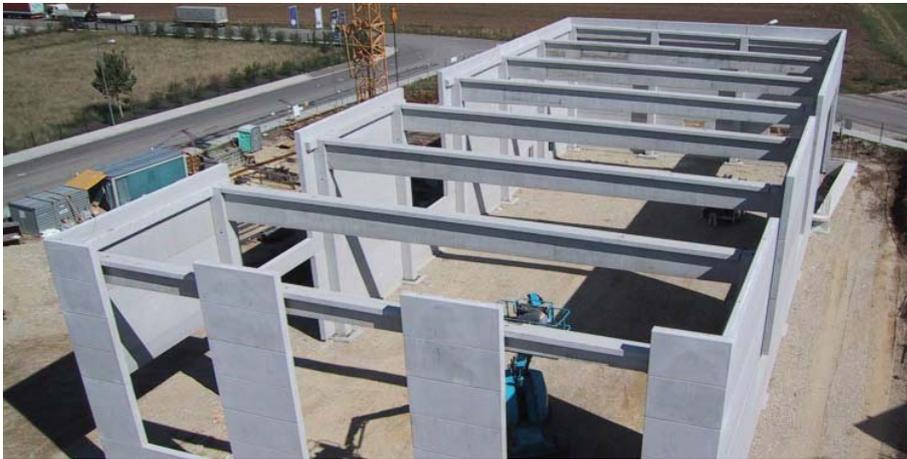
*Konstruktive Fertigteile aus SCC*
