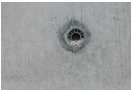
**Abb. 11: Ankerloch unabgedichtet**
