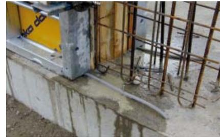
**Abb. 15: Vertikale Arbeitsfugen mit Bewehrungsdurchführung**
