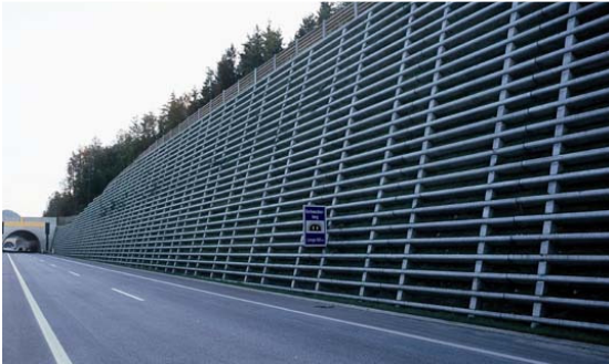
Raumgitterwand auf der A9, Pyhrnautobahn Foto und schematische Darstellung: Expertenforum Beton, Tagungsband Abdruck honorarfrei
