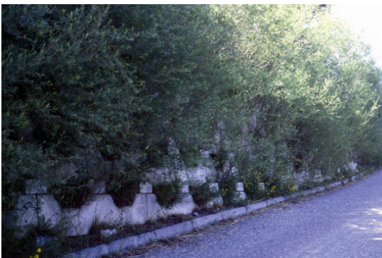
Betonkranerwand mit Weidensteckhölzern bepflanzt Foto und schematische Darstellung: Expertenforum beton, Tagungsband Abdruck honorarfrei
