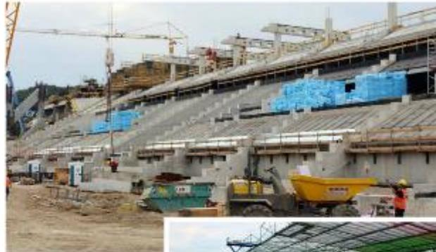
Die Optik spielte beim Bau der Tribüne eine wichtige Rolle: Die Sichtbetonflächen sollten frei von Lufteinschlüssen bzw. Poren sein und eine gleichmäßige Farbtonung aufweisen.
