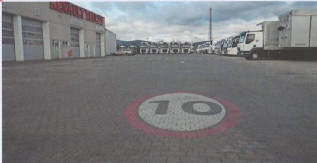
Der Baustoff Beton sorgt auch bei gepflasterten Großflächen jahrzehntelang für Stabilität. FOTO: VÖB
