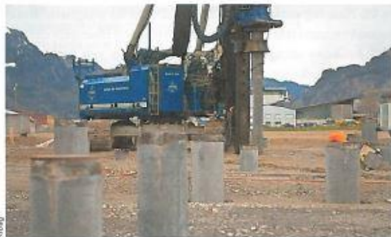
Energiepfahl-Feldtest in Eyschachen in der Schweiz.
