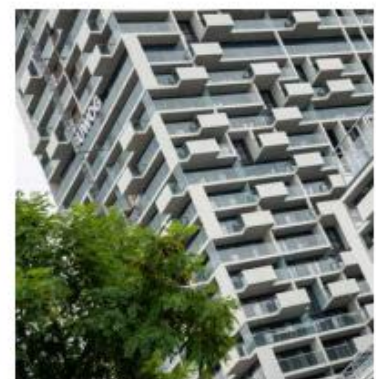
Die Balkone für den Marina Tower in Wien wurden als maßgeschneiderte Betonfertigteile vor Ort produziert
