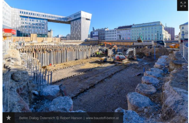
★ Beton Dialog Österreich © Robert Harson | www.baustoff-beton.at
