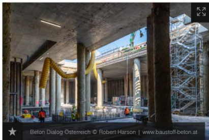
★ Beton Dialog Österreich © Robert Harson | www.baustoff-beton.at
