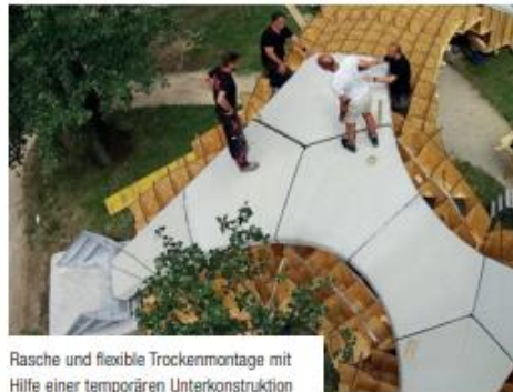
3D-gedruckt wurden die 53 Betonfertigteile bei Incremental3D in Siegraben (Bgld)
