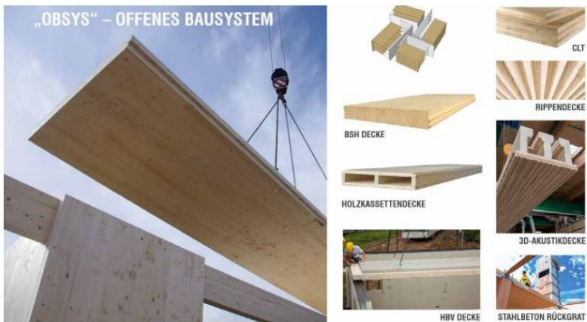
Das „offene Bausystem“ (Obsys) bedeutet wenige Elemente in oftmaliger Wiederholung mit einem hohen Grad an Vorfertigung seriell eingesetzt
