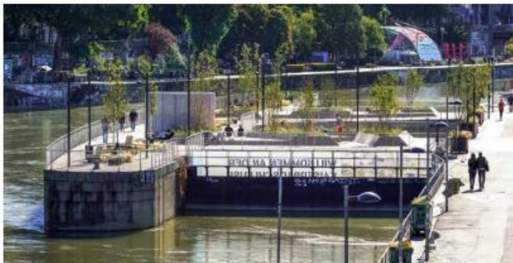
Konstruktive Fertigteile wurden in bis zu 30 Meter Tiefe verankert und bilden das Fundament der „Schwimmenden Gärten“
