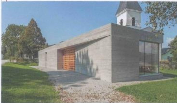
Beton, Holz und Glas sind die verwendeten Baustoffe dieses archaischen Baus, die Verglasungen sind raumhoch und großteils fix. FOTO: GERHARD MAURER
