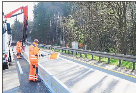
Die in Österreich entwickelten Betonleitschienen sind weltweite Exportschlager. (Dahms)
