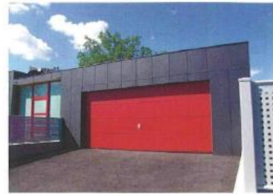
SONDERLÖSUNGEN. Schnauer realisiert auch architektonisch anspruchsvolle Sonderlösungen.
