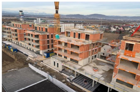
Der Rohbau des Projekts von Herbert Ritter. © Ritter
