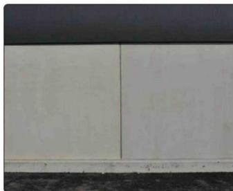
Optisch kein Unterschied: links ein Öko<sup>2</sup>-Beton-Element, rechts ein Element aus Standardbeton.
