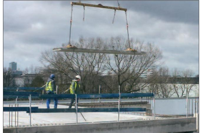
Bild 1: Versetzen von Spannbeton-Hohldielen mit Hebezangen
