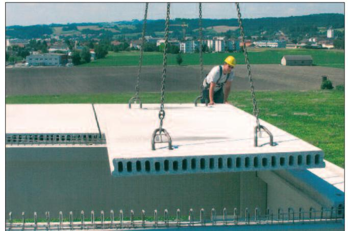
Bild 2: Versetzen von Hohldielen mit Versetzhaken
