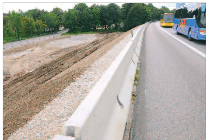
Bild 24: verankertes System an Böschung
