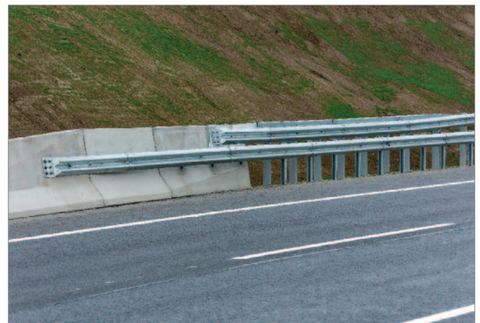
Bild 21: geprüfte Übergangskonstruktion gemäß ÖNORM EN 1317-4
