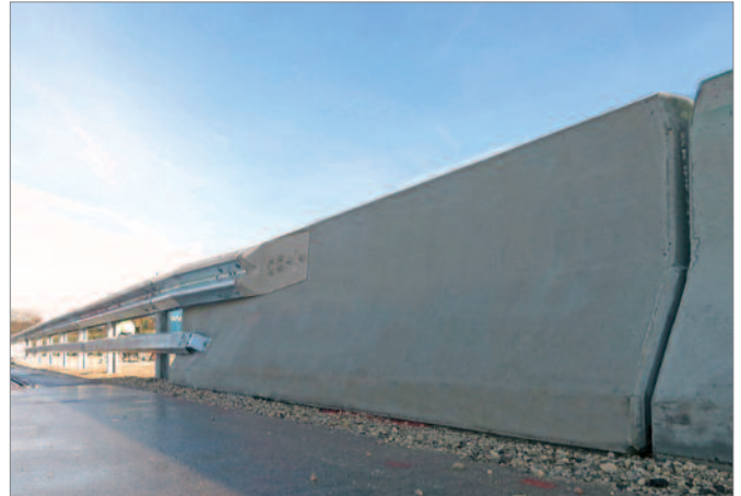
Bild 26: geprüfte Übergangskonstruktion gemäß ÖNORM EN 1317-4
