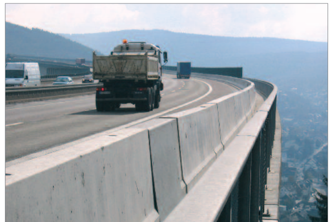
Bild 25: Randabsicherung auf Brücke inklusive Dilatation
