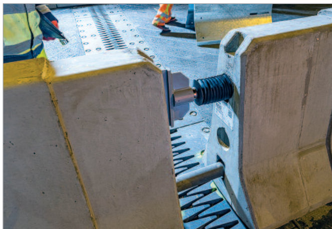
Bild 20: Leitwand mit Brückendilatation für Dehnweg 25 cm
