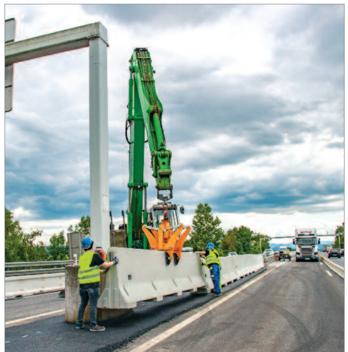
Bild 37: rasche Montage mit Hebezeuge
