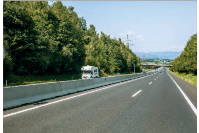
Bild 13: Leitwand innerhalb des Mittelstreifens
