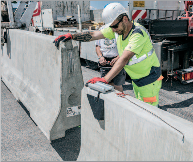
Bild 39: Zusammenschluss der Elemente
