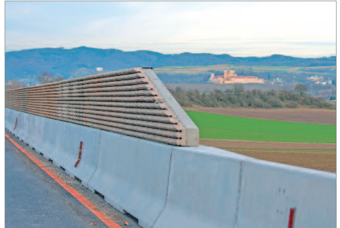
Bild 31: Leitwandsystem mit kombinierter Lärmschutzwand
