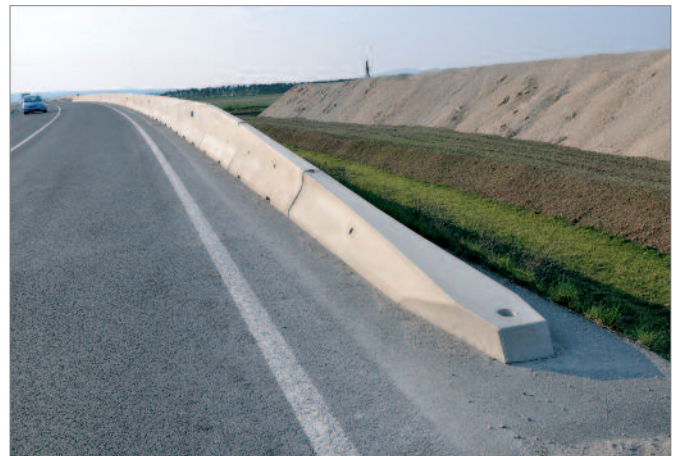
Bild 27: Rampe als Anfangskonstruktion
