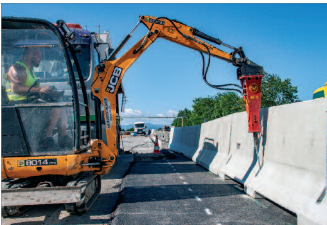
Bild 42: Verankerung der Elemente
