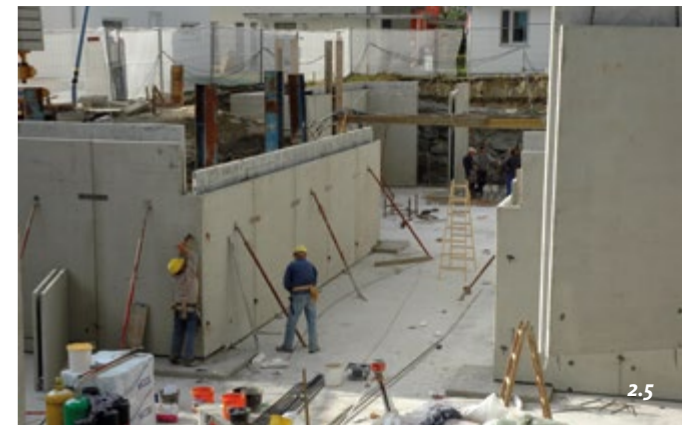
Bild 2.4: Geschalter Keller/Transportbeton
