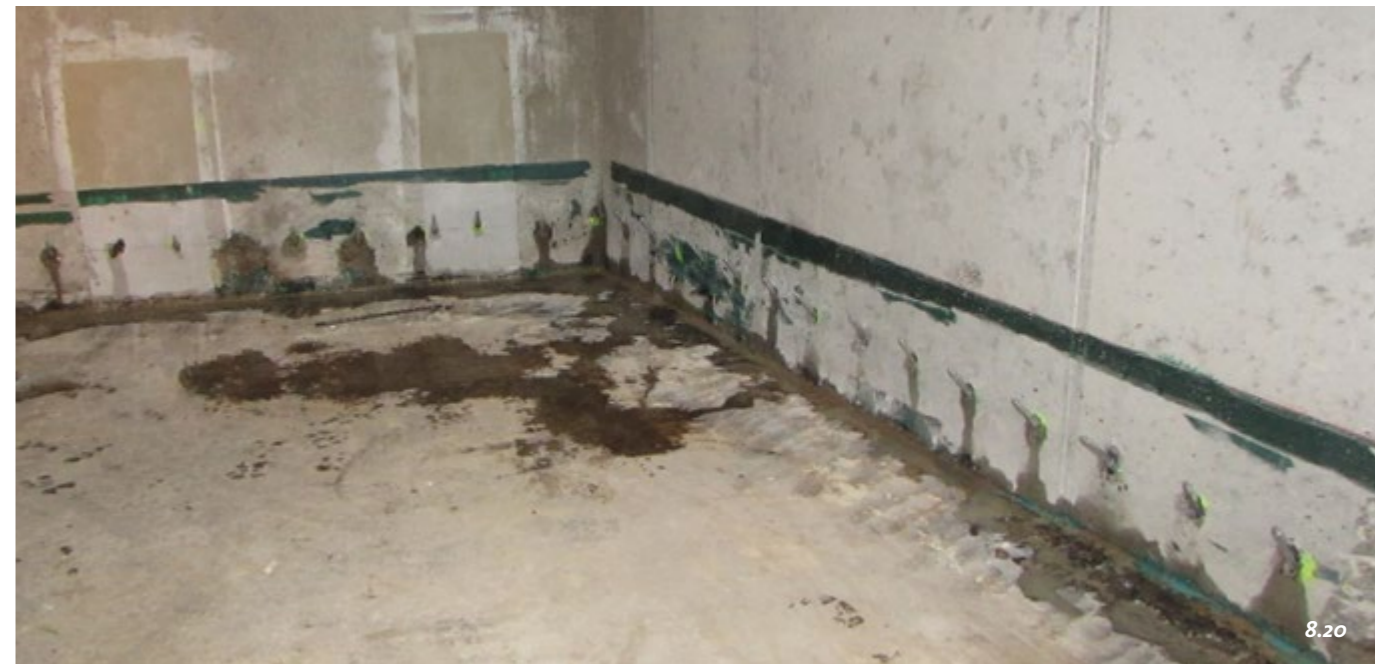
Bild 8.20: Beispiel für eine nachträgliche Injektion bei einer undichten Kellerwand © Lindner
