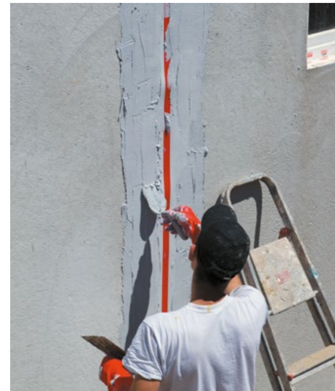
Bild 8.16: Verspachtelung Fuge © Z+B
