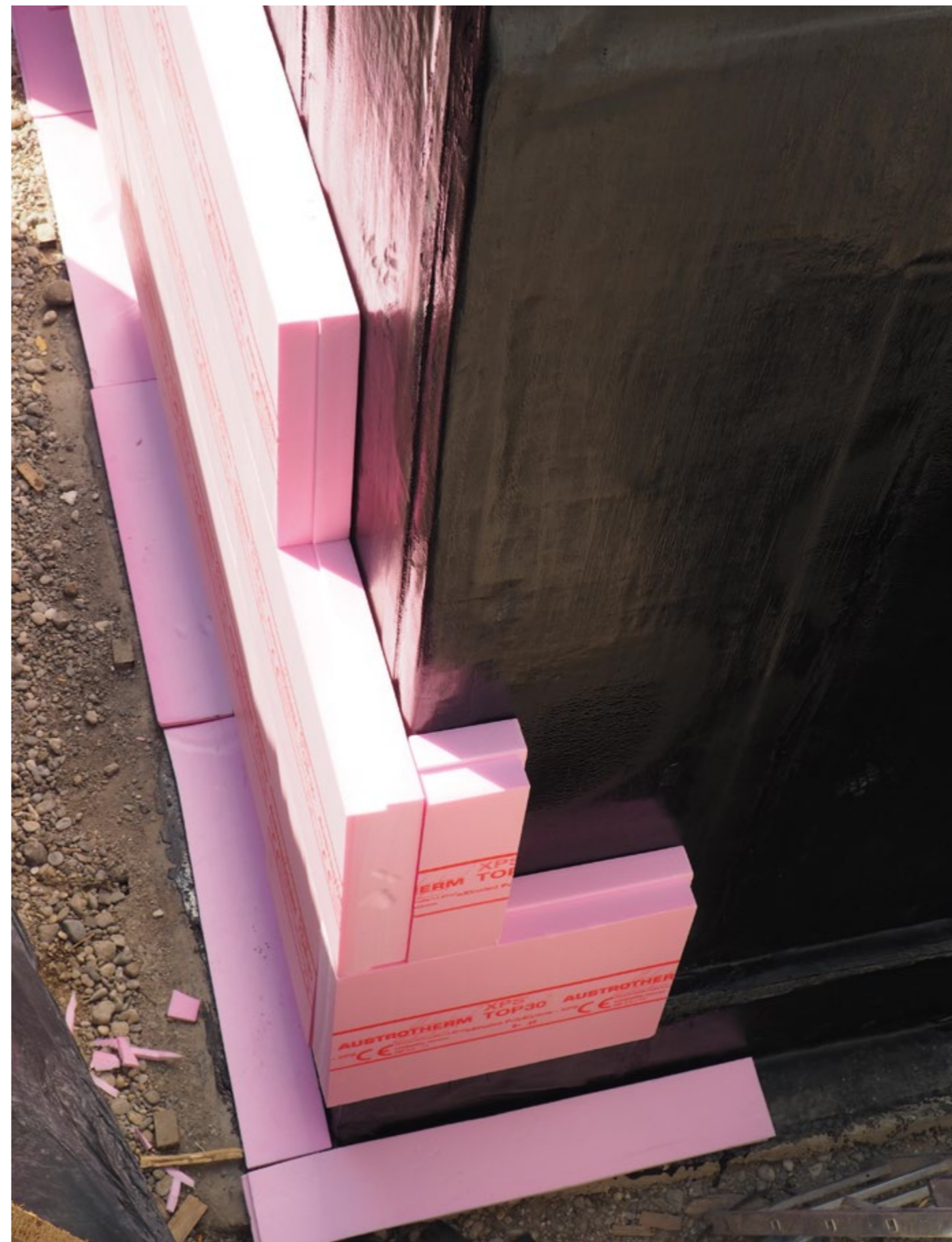
Bild 8.2: Kellerabdichtung mit Anstrich ▶ und Perimeterdämmung
