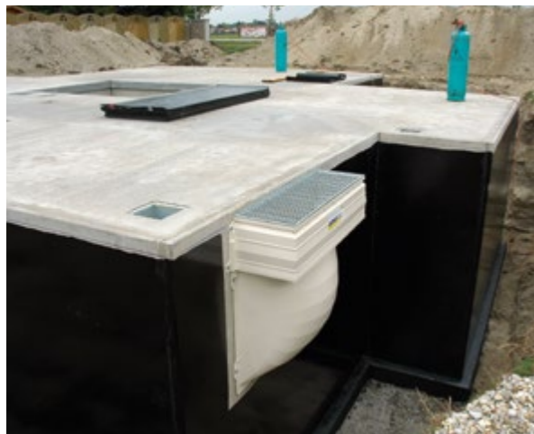
Bild 2.1: Keller isoliert mit Fertigteil-schacht © Z+B/Schönbichler
