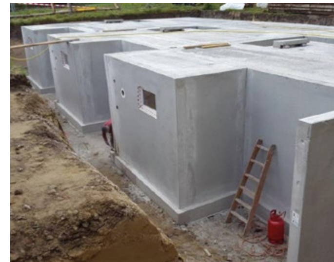
Bild 8.13: Betonfertigteilkeller Weiße Wanne © Z+B/Schönbichler
