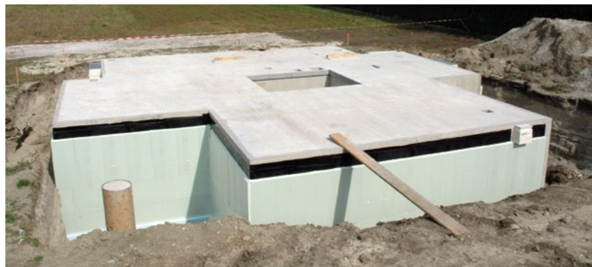
Bild 2.3: Rohbau – fertiger Keller
