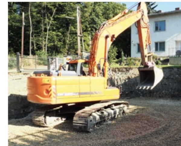
Bild 3.5: Kelleraushub/Einbringung Rollierung
