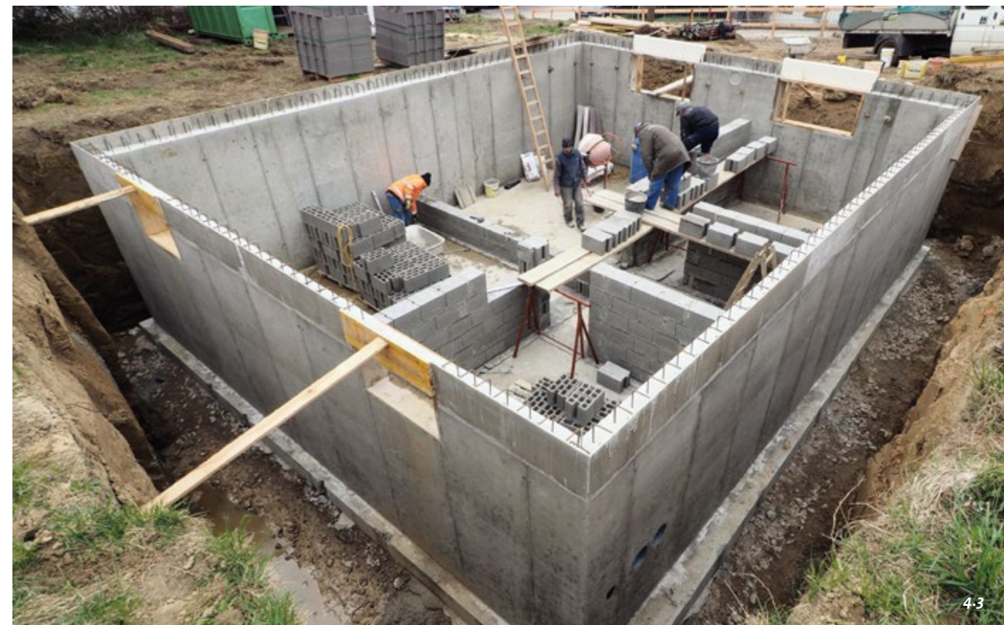
Bild 4.2: Keller mit Betonfertigteilen ▶
