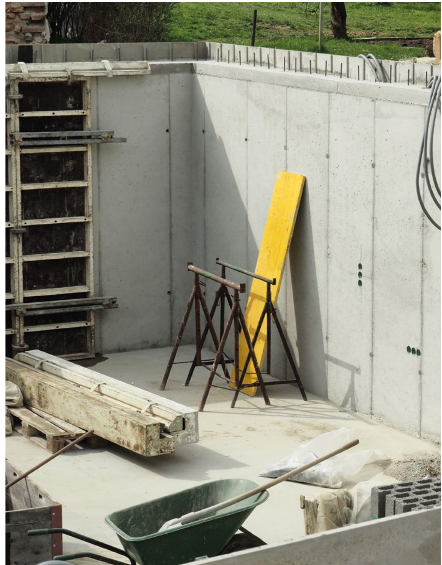
Bild 2.2: Innenansicht Keller in Bau ▶ © Z+B/Schönbichler
