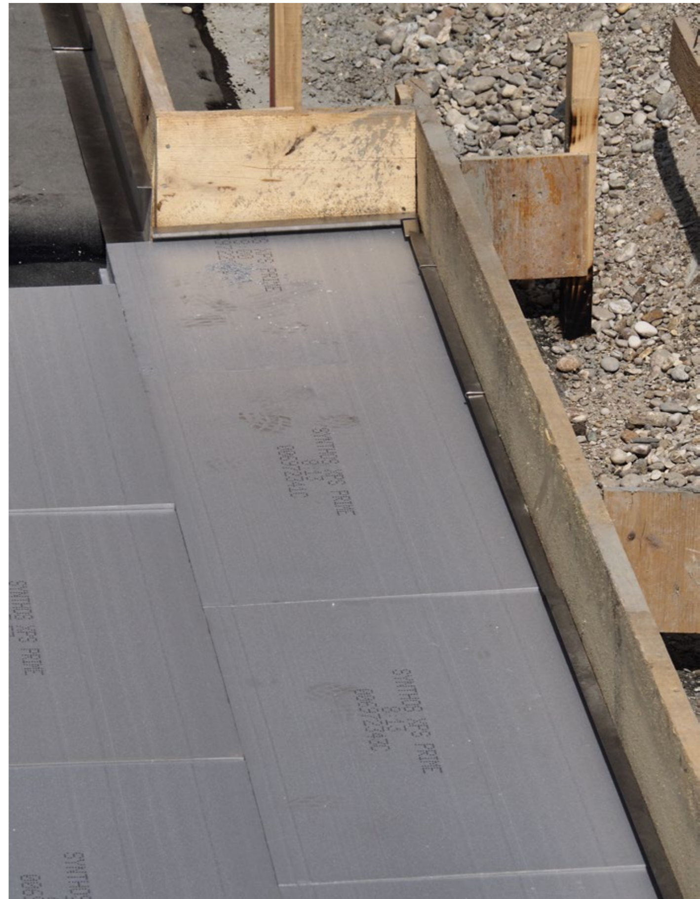
Bild 5.1: Dämmung Bodenplatte Keller ▶
