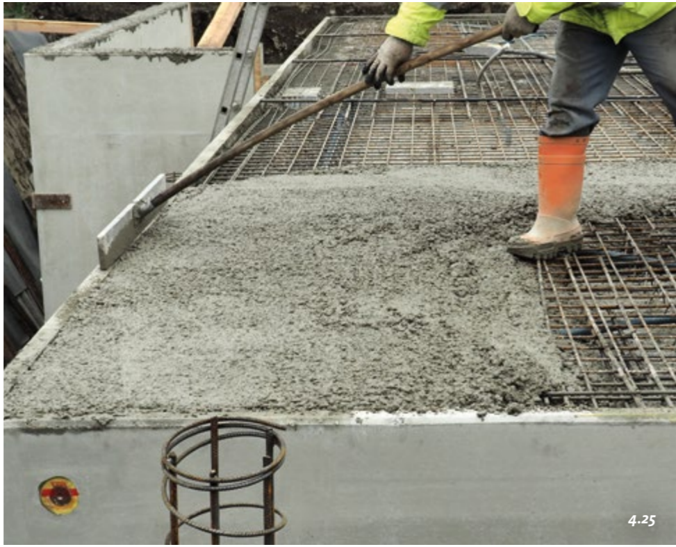
Bild 4.25: Betoneinbringung Kellerdecke
