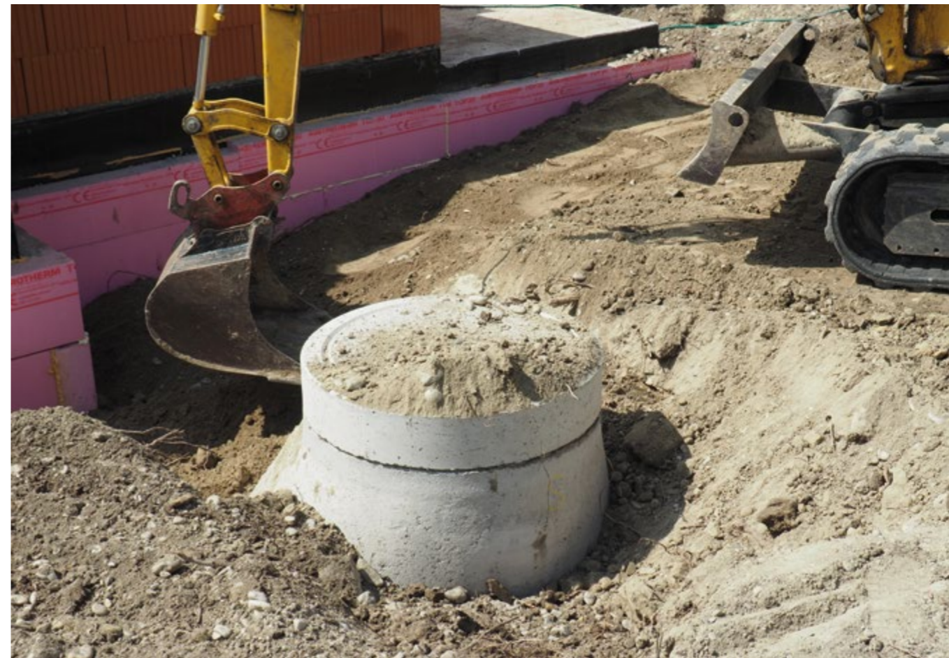
Bild 8.8: Verlegung Kanalschacht © Z+B/Schönbichler
