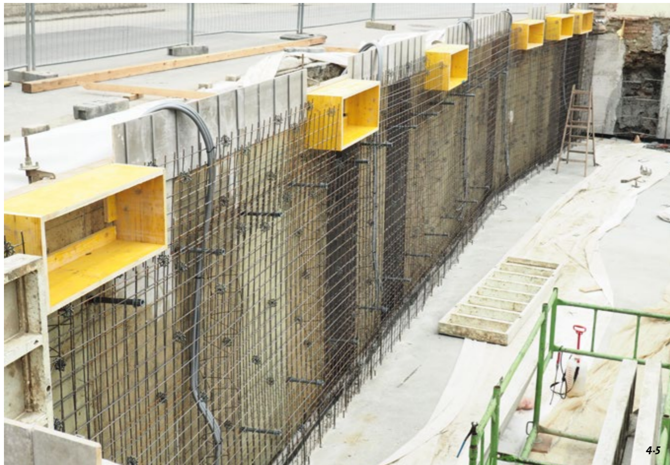
Bild 4.5: Einbauten geschalte Wand
