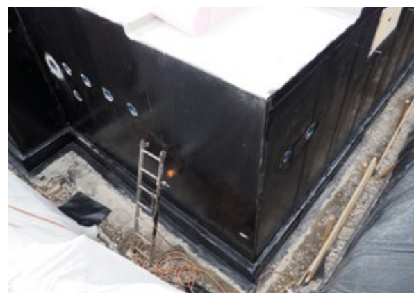
Bild 8.5: Vertikalabdichtung Kellerwand/Anstrich
