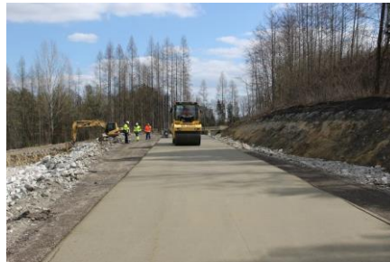
Innovativer Walzbeton auf 500 Metern Teststrecke in der Südsteiermark. Belastbar, bleibt frei von Spurrillen, verformt sich nicht in der Sommerhitze
