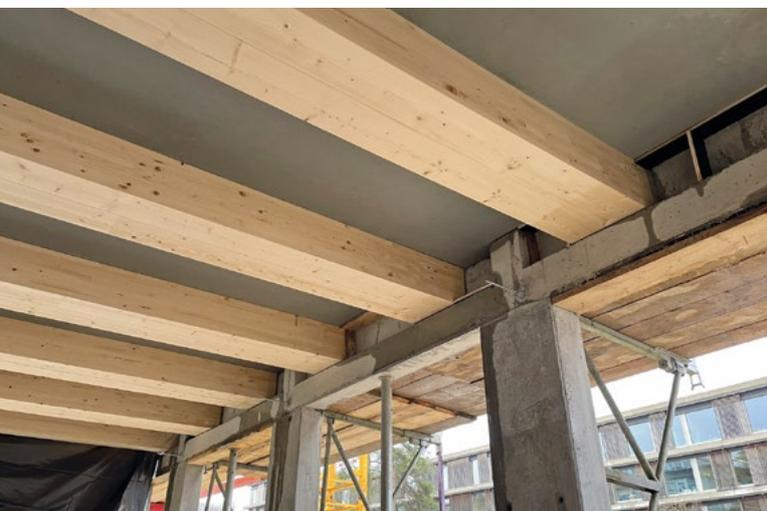
Montierte Holz-Beton-Verbunddecken auf der Baustelle.
